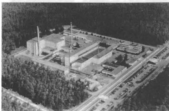
写真1 WAK再処理プラントの全景
