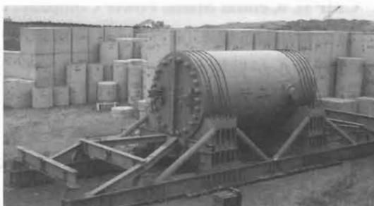
写真3 バーンウエル処分場トレンチに定置された原子炉容器廃棄体
