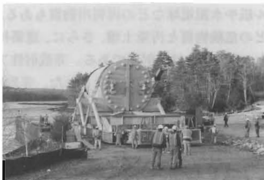
写真1 サイトを離れる原子炉圧力容器
