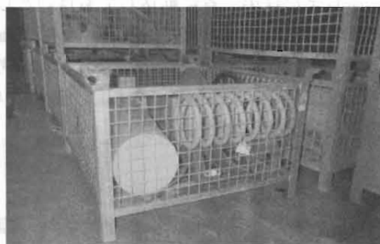
写真2 格子状ボックスに収納された解体物
